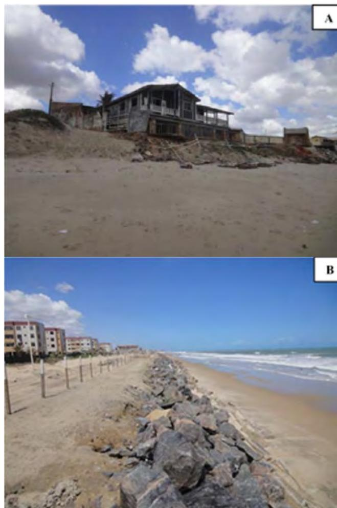
**Figura 5.** Imóveis em área de risco na Praia do Icaraí, em dezembro/15. Imagem de uma casa na frente urbana marinha que está sendo pouco a pouco destruída pela erosão costeira (A); Enrocamento construído por iniciativa dos condôminos para proteção do patrimônio edificado (B).
