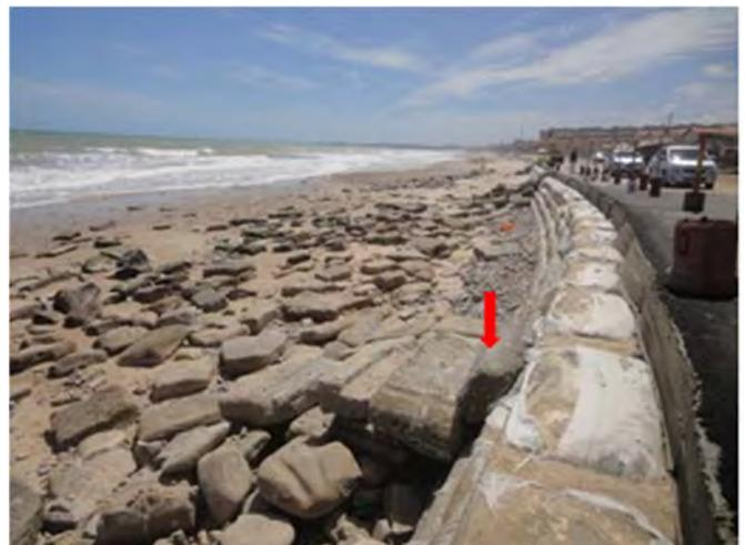
**Figura 4.** Blocos de concreto dispersos pela faixa de areia da Praia do Icaraí, em dezembro de 2015. A seta vermelha indica uma escada improvisada com os blocos de concreto para acesso à praia.
